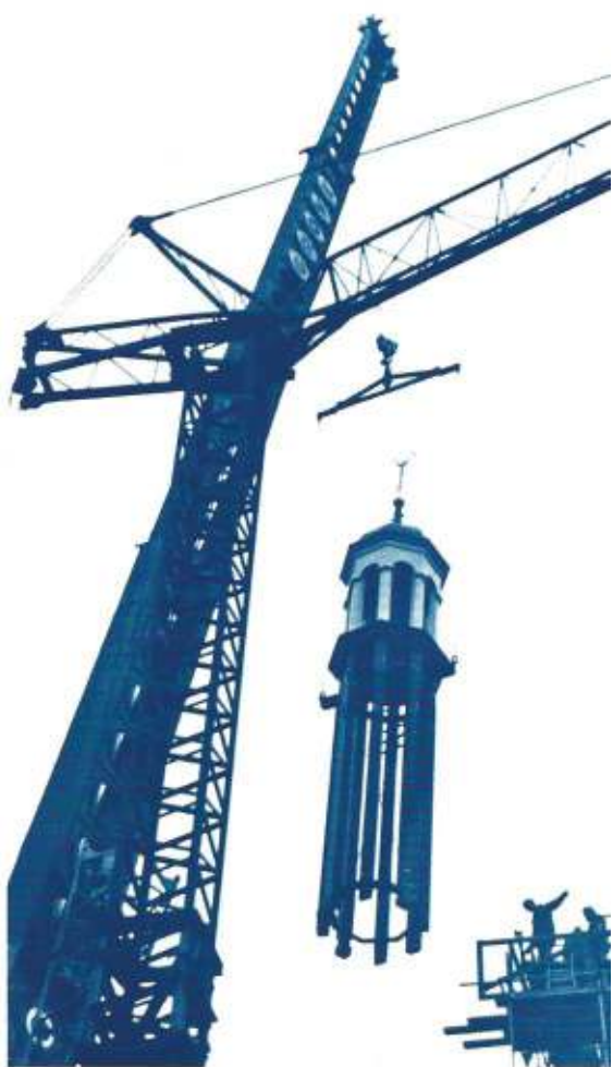
Het plaatsen van de torenspits op de toren van de Grote Kerk
